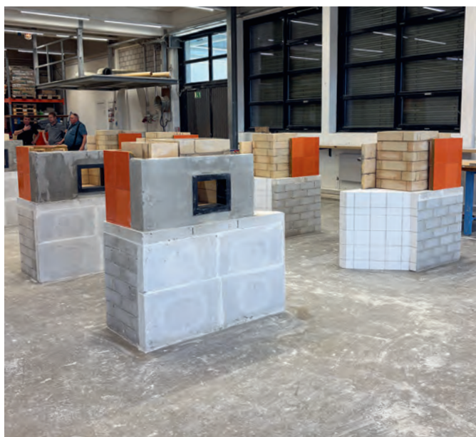
Les travaux achevés
