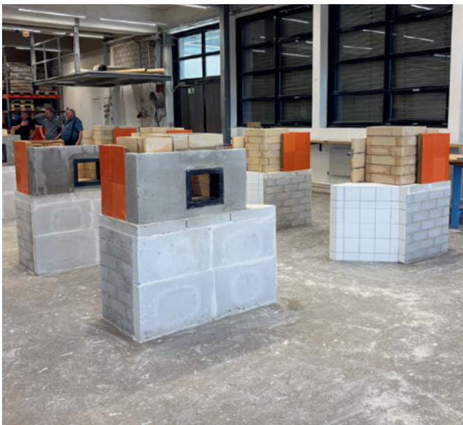
Die fertigen Arbeiten
