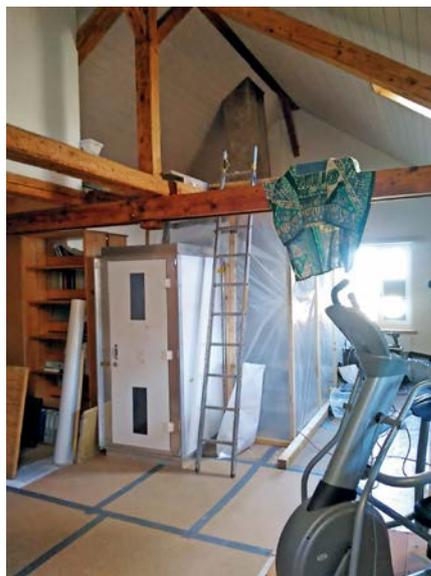
Zone installée de l'extérieur avec un sas, à droite, pas bien visible l'AMD avec l'ouverture dans la fenêtre où est monté le tuyau pour l'aspiration de l'air purifié.
