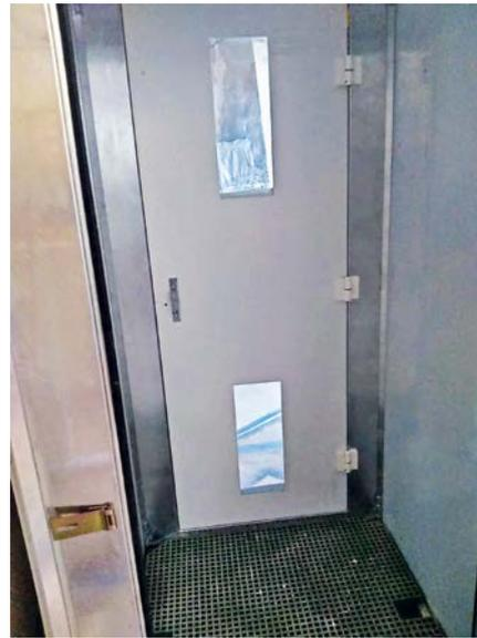
Sas depuis l'intérieur avec ouverture de compensation dans la porte extérieure. C'est ici que les sacs sont déposés un à un, éventuellement arrosés avec un jet d'eau, la porte intérieure fermée puis la porte extérieure est ouverte et le sac peut être enlevé. La dépression reste ainsi toujours préservée.
