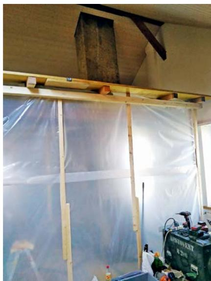
Construction de zone avec toit accessible pour crépir le conduit de fumée
