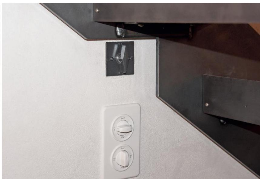
Manipulation des clapets des gaz de fumée. À l'étage et dans les combles ils sont à commande électrique
