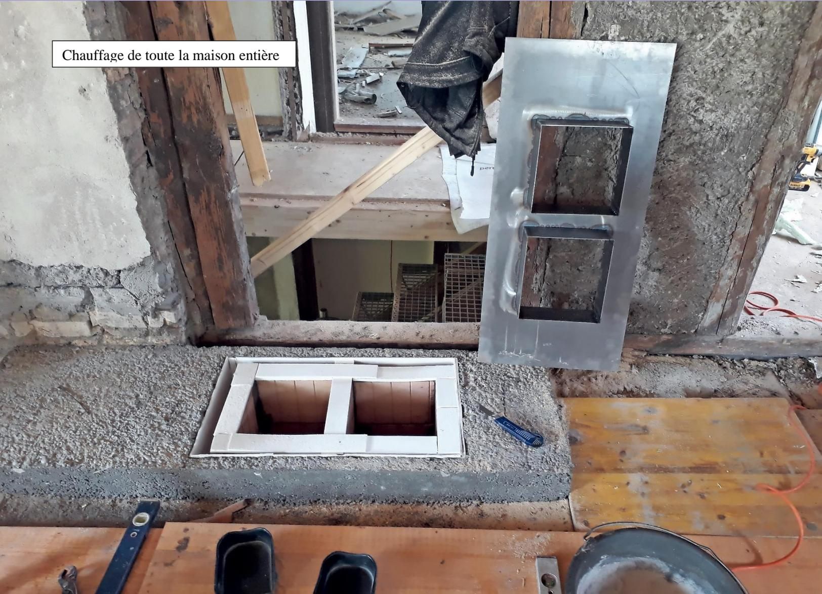
Passage rez-de-chaussée à l'étage : Grâce à l'intercalaire métallique les mouvements dans la construction du sol sont absorbés et l'étanchéité de l'installation est garantie.
