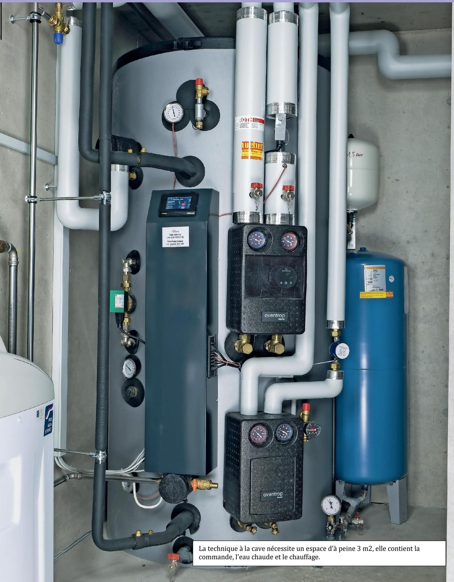
La technique à la cave nécessite un espace d'à peine 3 m<sup>2</sup>, elle contient la commande, l'eau chaude et le chauffage.
